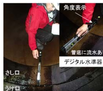
写真-1 測定状況
